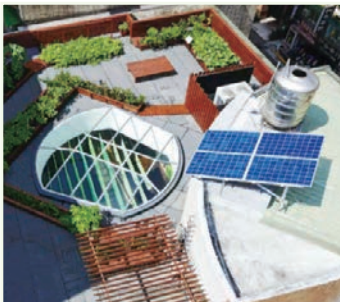
太陽能發電暨雨水回收生態水培綠屋頂
